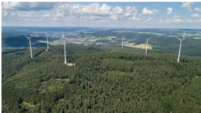
Der Windpark Buchenau mit zehn Enercon E-115-Anlagen mit je drei MW Leistung ©Buchenau Wind GmbH & Co KG, Luca Heil
